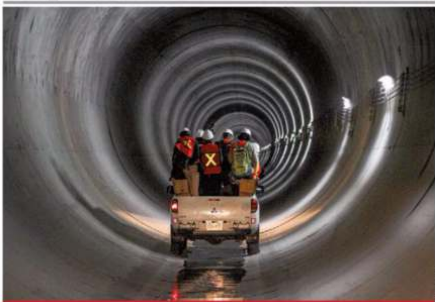
Personal de Conagua presentó ayer la obra terminada.
