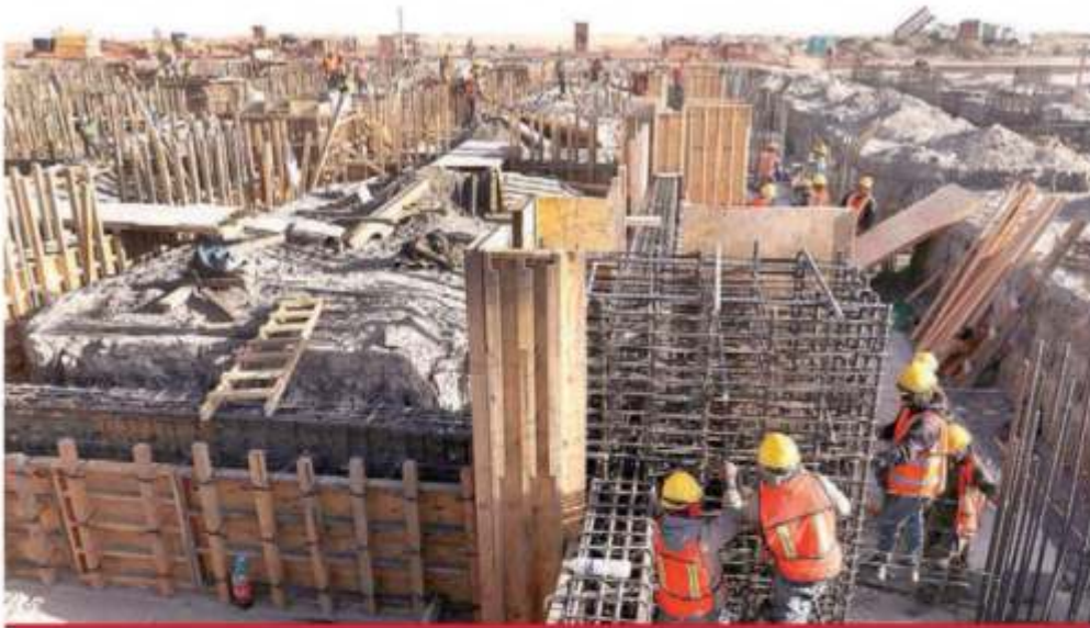
Cimentación de las futuras salas centrales del nuevo aeropuerto de Santa Lucía.
