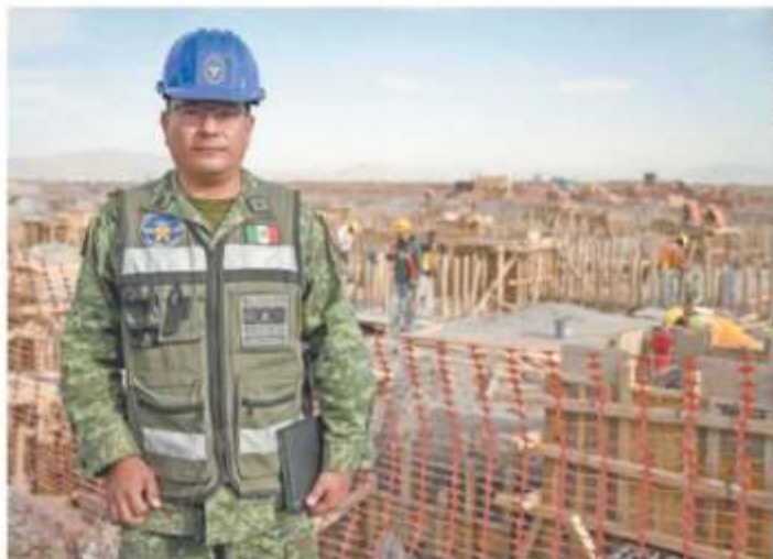
El mayor Miguel Ángel Guerrero Cruz dice a conocer que en este momento los trabajos registran un avance general de 2.20% en la etapa de cimentación y terracerías.
