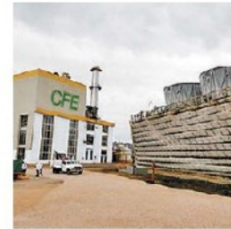
Termoeléctrica. J. CARBALLO
