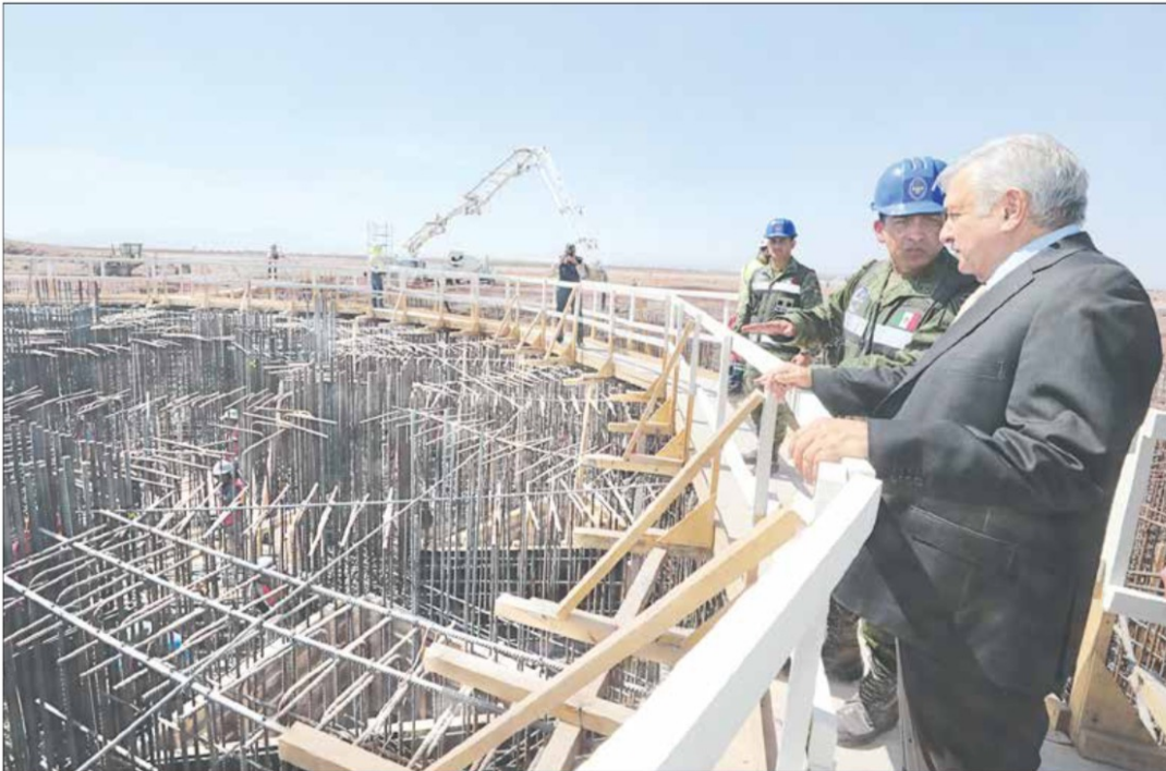
▲ La conmemoración del 105 aniversario de la Fuerza Aérea Mexicana se convirtió en una visita de supervisión del presidente Andrés Manuel López Obrador a las obras del nuevo aeropuerto
