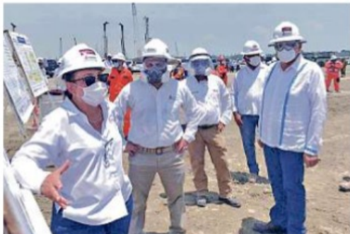
Nahle supervisó el viernes con el Gobernador Augusto López las obras en Dos Bocas, que no han parado ni con la pandemia.
