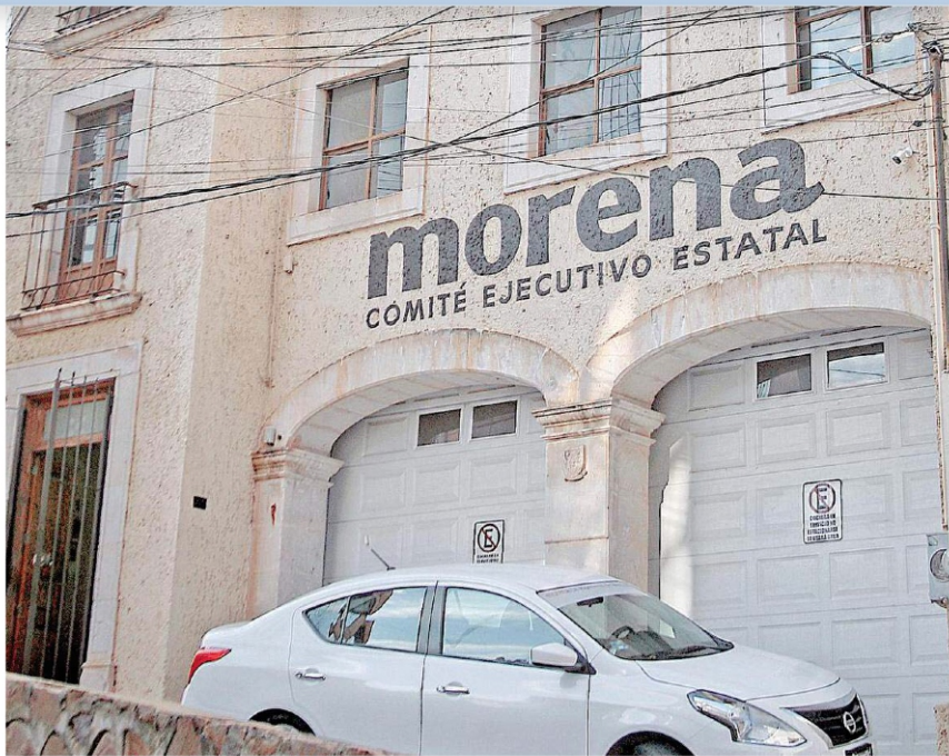
El edificio que compró Morena de manera irregular, según el diputado Omar Carrera. / FLOR CASTAÑEDA
