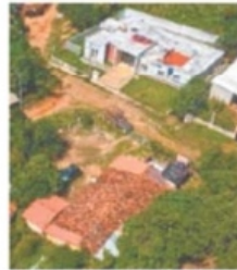
El hospital está en medio de una zona arbolada.
