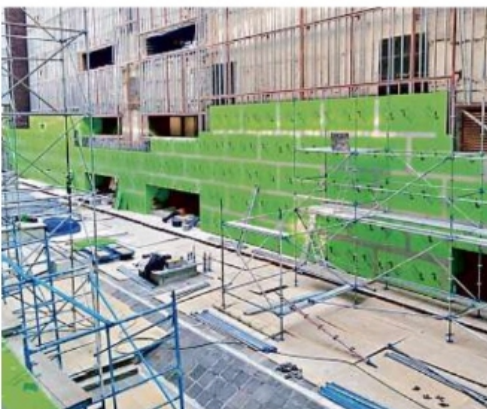
Paneles que se instalan en las fachadas de cinco edificios de San Lázaro, donde se ubican comisiones y oficinas.
