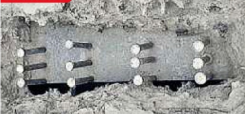
Fallas estructurales, falta de pernos (foto) y mala soldadura provocaron el accidente en Línea 12, según dictamen preliminar.
