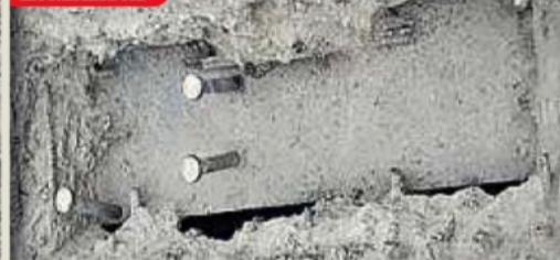
Fallas estructurales, falta de pernos (foto) y mala soldadura provocaron el accidente en Línea 12, según dictamen preliminar.
