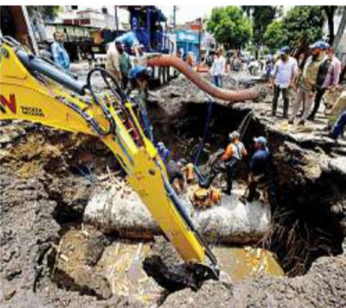
Personal de Sacmex y Protección Civil trabaja en la reparación del socavón que se abrió en Canal de Miramontes.
