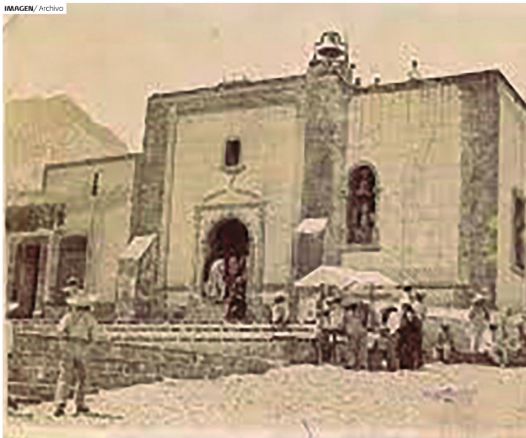
DESIGNARON algunos edificios para albergar dependencias.
