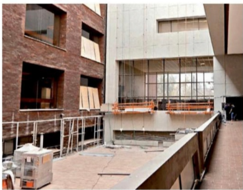
Los trabajos en la fachada del edificio H están en curso.
