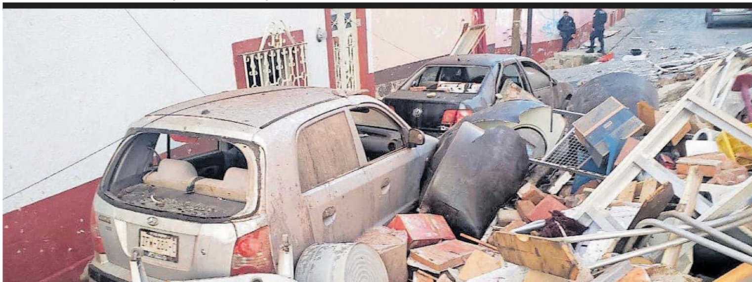
Producto del siniestro, dos automóviles que se encontraban estacionados en la zona resultaron con daños/CORTESÍA: PROTECCIÓN CIVIL MUNICIPAL
