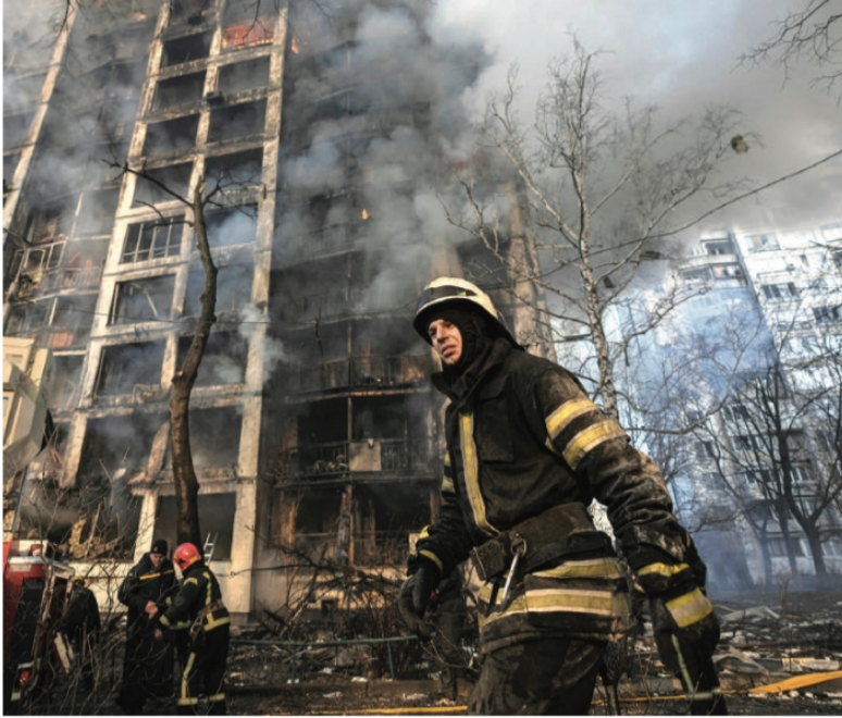
UN BOMBERO camina junto a un edificio destruido en Kiev, ayer; Rusia estrecha cerco.
