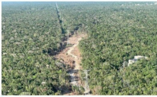
El juez ordenó detener las obras y la tala de árboles.
