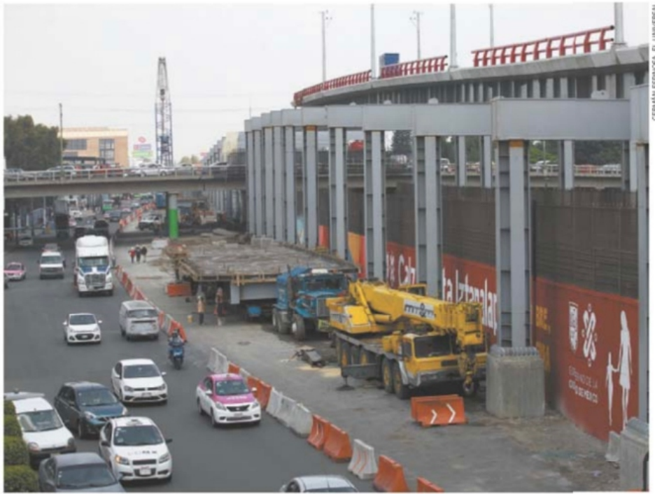
La nueva línea del Trolebús Elevado correrá sobre el Eje 8 Sur Ermita Iztapalapa.
