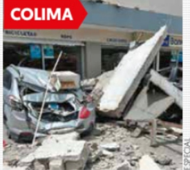
MANZANILLO. Los derrumbes y colapsos causaron dos muertes.
