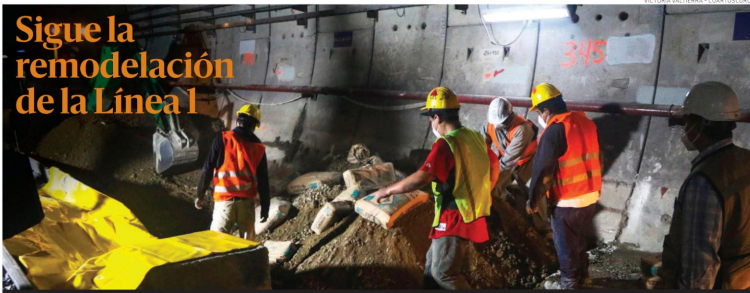
Los trabajos de modernización de la Línea 1 de Metro avanzan, como el cambio de vías que alcanzará 22 kilómetros. Las autoridades estiman que las obras cumplan el programa, por lo cual es seguro que la primera etapa concluya el próximo febrero.
