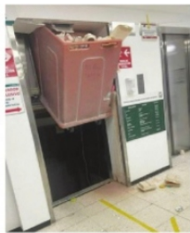
FALTA DE MANTENIMIENTO, en elevador del IMSS.
