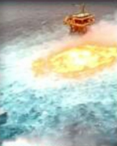
JULIO, 2021. Gasoducto de la plataforma KU-C, en la Sonda de Campeche.
