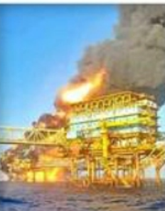
JULIO, 2023. Plataforma Nohoch-A en Cantarell, en Campeche.
