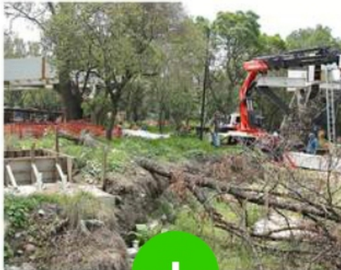
Los trabajos para construir el puente peatonal Chivatito ya iniciaron.
