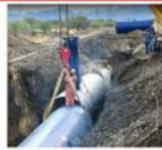
A 4 días de "inaugurado", el acueducto sigue en obras.
