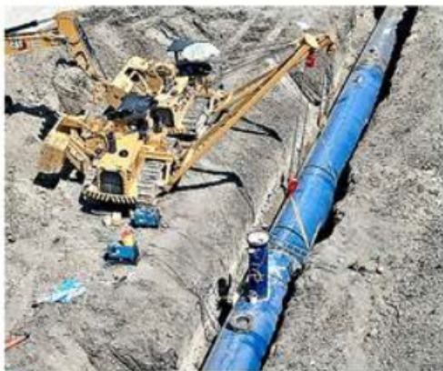
Un segmento del ducto, atrás de la Refinería de Cadereyta, es sostenido por dos grúas para apenas ser unido ayer.
