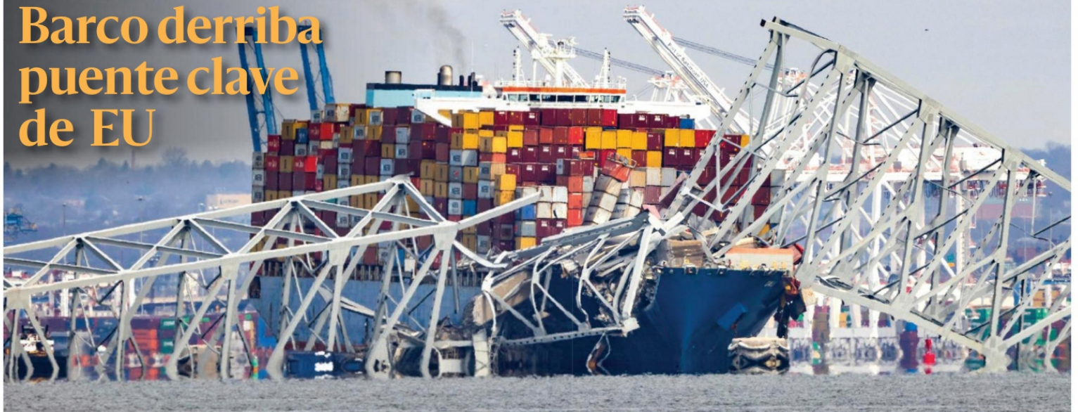
El buque de carga con 10 mil contenedores quedó incrustado entre el hierro del puente colapsado debido a la colisión. La nave había salido del puerto de Baltimore.
