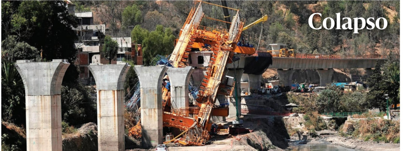
Una grúa o "lanzadora de dovelas" de alrededor de más de 200 metros y de alrededor de 800 toneladas se desplomó la madrugada del miércoles durante una maniobra de desplazamiento de dovelas en el tramo Presa Tacubaya - Terminal Observatorio del Tren Interurbano. PAG 13
