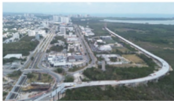
EL PUENTE reducirá el tiempo entre el aeropuerto de Cancún y la zona hotelera.
