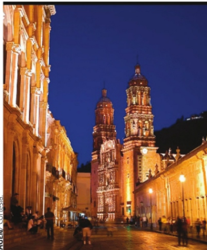
FALTA MANTENIMIENTO AL CENTRO HISTÓRICO , se ve descuidado, sucio y la iluminación escénica incompleta.
