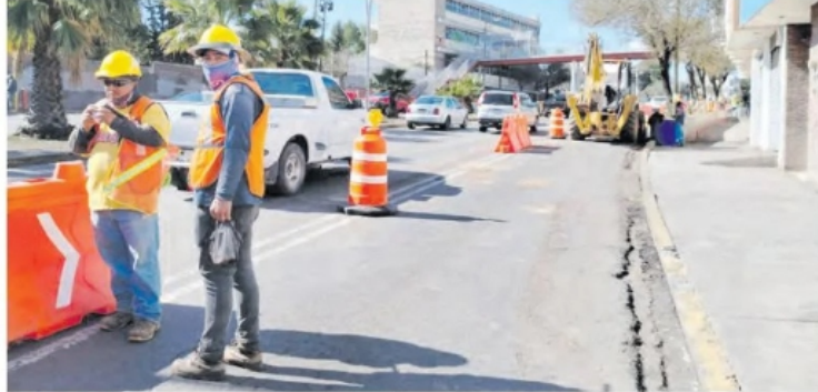
LOS TRABAJOS preliminares se realizan a la altura de la Secundaria Técnica 1.
