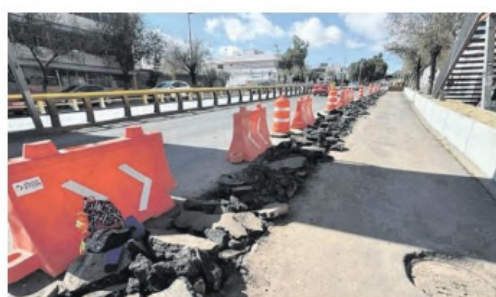
INICIARON trabajos preliminares para el viaducto elevado.
