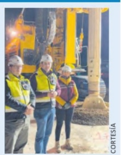
CON MAQUINARIA especial realizaron las primeras perforaciones.
