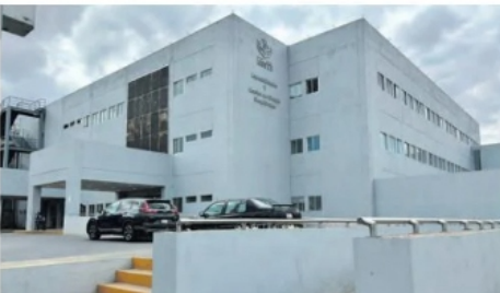
EDIFICIO de especialidades del Hospital General del instituto.
