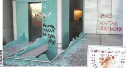
DAÑOS al MUAC, en Ciudad Universitaria, ayer.
