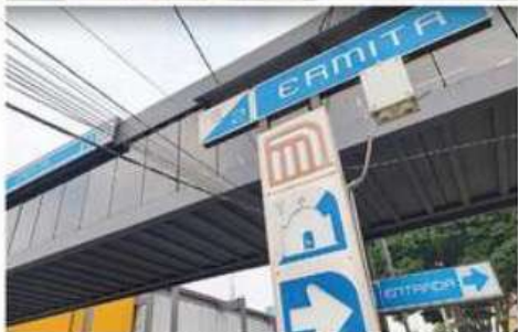
Las obras en la Línea 2 fueron entregadas por las empresas INDHR y Gysle con retraso.
