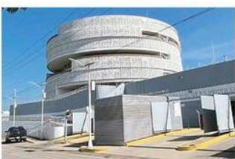
La sede Judicial construida por la Sedena presenta múltiples fallas.
